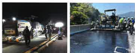
傷んだ舗装の撤去 床版防水工の施工
