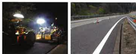
路面損傷箇所の補修 路面標示の施工
