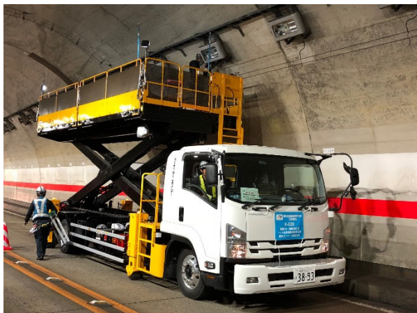
《設備点検・清掃》
